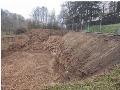
Čistírna odpadních vod
