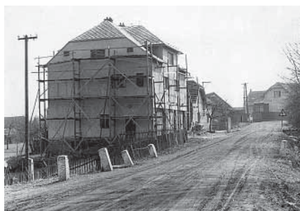
Hasičárna před dokončením
